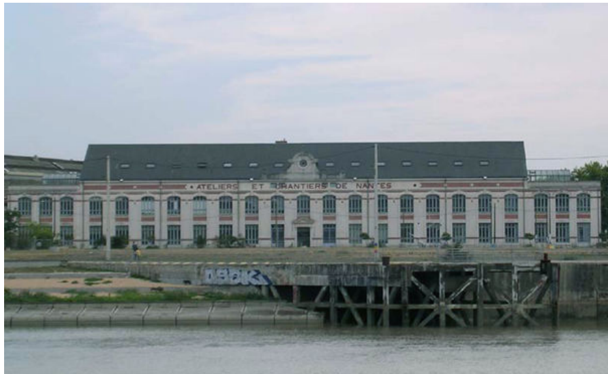
Figure 12 : Le bâtiment de direction des anciens chantiers navals Dubigeon, après réhabilitation
