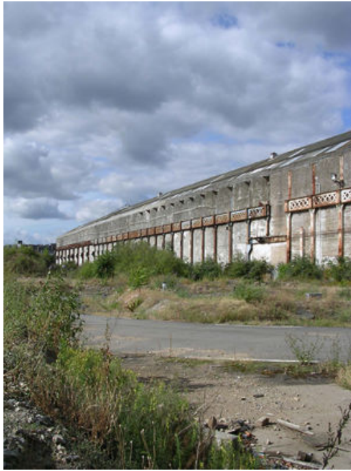
Figure 7 : Friche industrielle sur l'Île de Nantes
