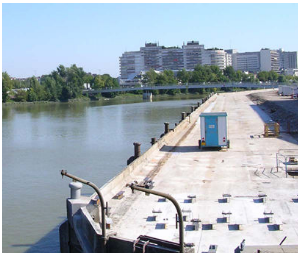
Figure 9 : Le retraitement du Quai François Mitterrand
