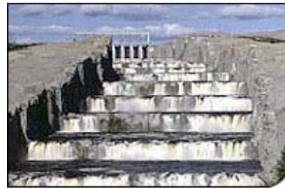
Figure 2 - Évacuateur de crues du réservoir Robert-Bourassa. (Photo : Hydro-Québec)
