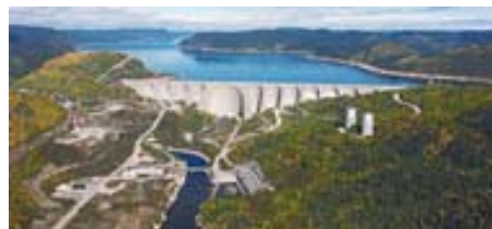
Figure 7 - Le barrage Daniel-Johnson. Complexe hydroélectrique Manicouagan, Québec. Photo BBC4, reproduite dans Le Devoir , 14 juin 2003.
